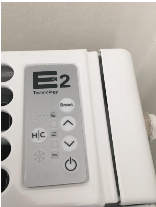
Abbildung: Bedientableau Heizkörper
