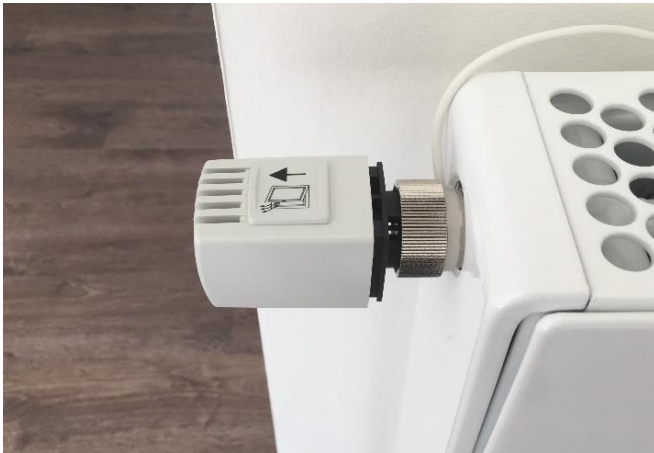
Abbildung: Thermostatventil
