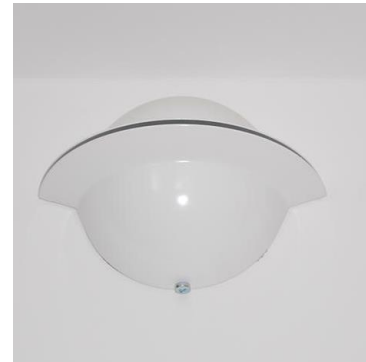
Abbildung Zufuft: Zuluftventil in den Wohnräumen
